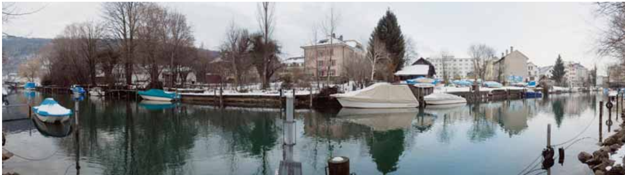
Das von einer allfälligen Agglolac-Erweiterung betroffene Gebiet reicht vom Fussgängerbrücklein aus Beton (ganz links) bis zur befahrbaren Brücke in Richtung Barkenhafen (rechts).
