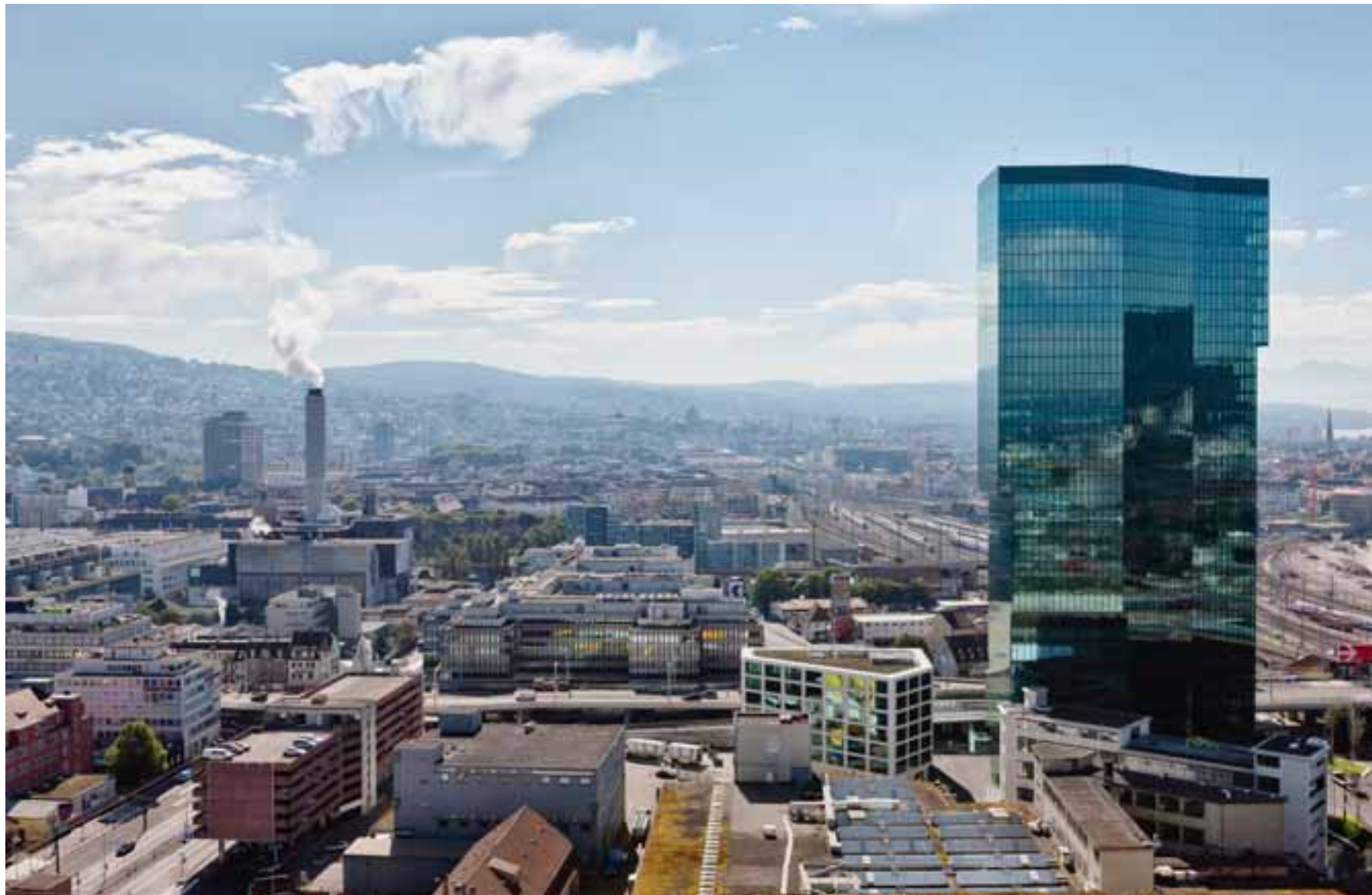
Der Generalunternehmer Steiner baute in Zürich West das 126 Meter hohe Geschäftshaus Prime-Tower, das höchste Gebäude der Schweiz - die Chancen stehen für ihn und zwei weitere mögliche Partner gut, dass er in Nidau einst Agglolac verwirklichen wird. Bild: ky
