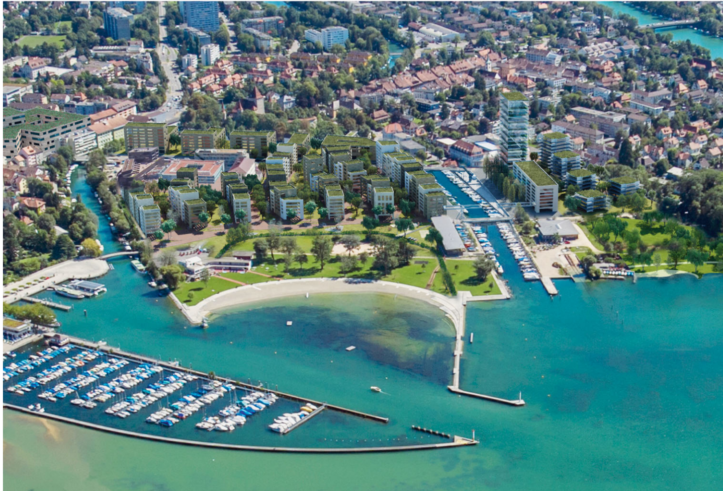
Le projet lacustre sied sur un site archéologique d'importance, qui doit être mis à jour et documenté avant sa destruction partielle. AGGLOLAC.CH
