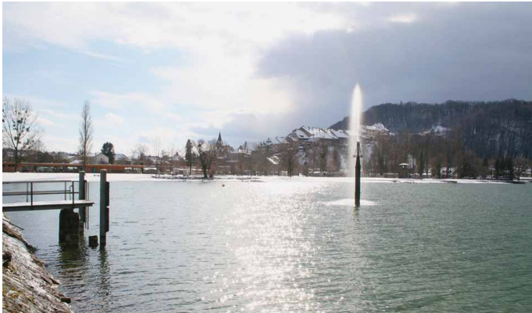
Ein Hauch von Genf: Die Fontäne der Wasserlilie bei Erlach erinnert ein wenig an den Jet d'eau bei Genf. Derzeit spritzt es wegen der defekten Pumpe allerdings überhaupt nicht. zvg/a
