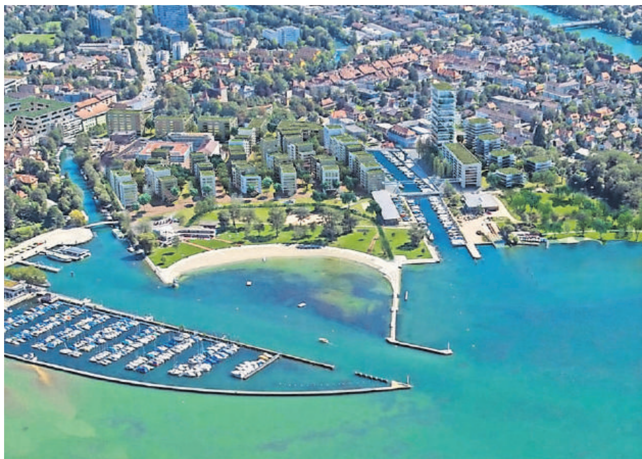
Ein Hochhaus und ein Bootshafen wie in Südfrankreich: So soll das Agglolac-Quartier aussehen.
